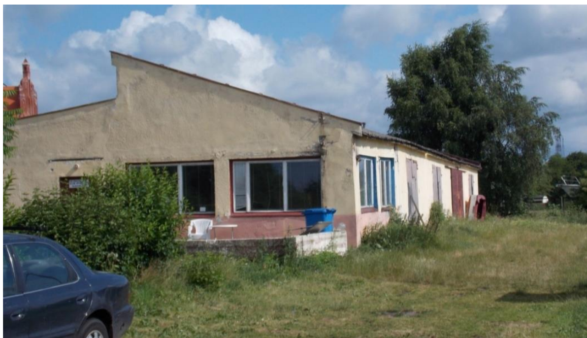
Zdjęcie 5. Remontowane pomieszczenia klubu „Albatros”
