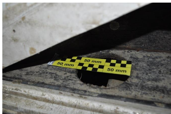
Zdjęcie nr 17. Wlot powietrza do pomieszczenia silników jachtu
