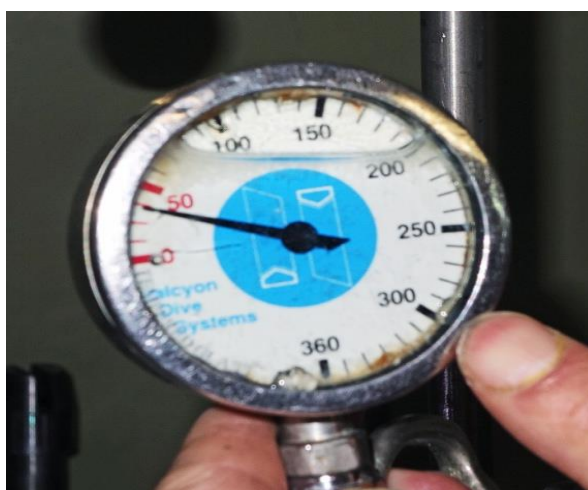
Zdjęcie nr 9. Miejsca wycieku wody
