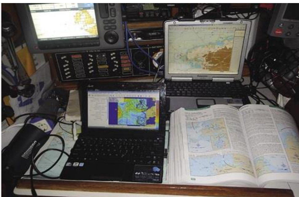
Zdjęcie nr 3. Tablica bezpieczników 12V i urządzenia radiowe (źródło: armator).
